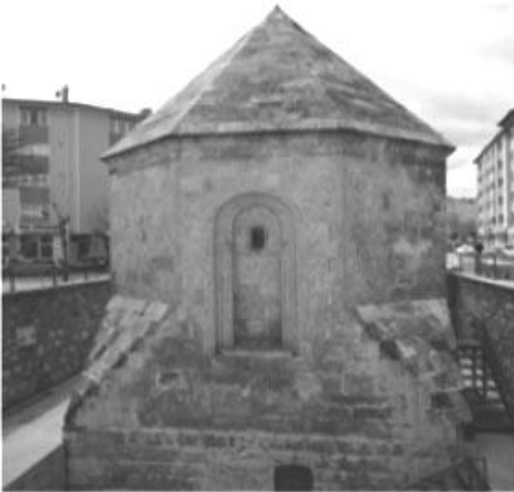
(لوحة:3)؛ تربة أخي الأمير أحمد ذات القبة المخروطية؛ ويتضح بها الشطوف؛ تصوير الباحث.
